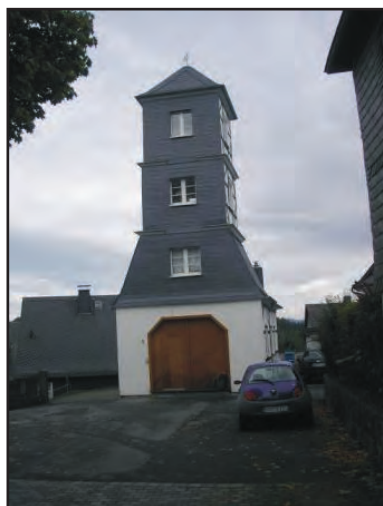
zum Wohnhaus umgenutztes altes Feuerwehrgerätehaus (Rittergasse 1)
