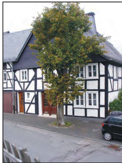
Zweiflügeliges Fenster mit Kämpfer: An der Kirche 3
