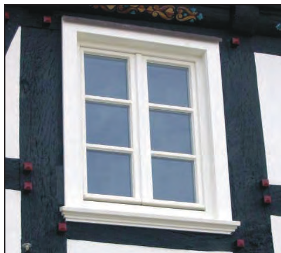
2-flügeliges Holzfenster mit Sprossenteilung, Setzholz, Wasserschenkel, Bekleidung und Holzfensterbank (Oststraße 5)
