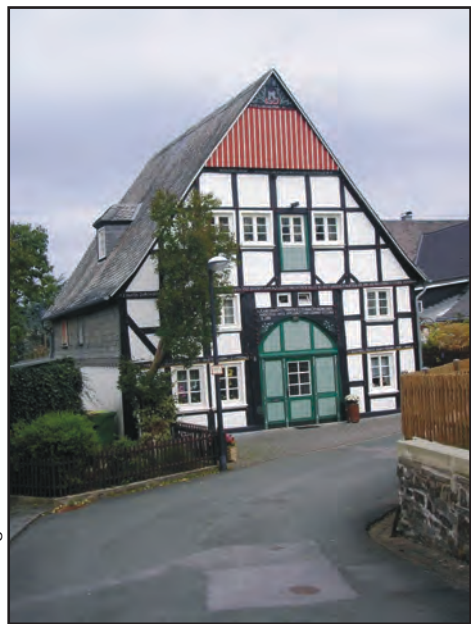
Hervorragende Fassade An der Kirche 8
