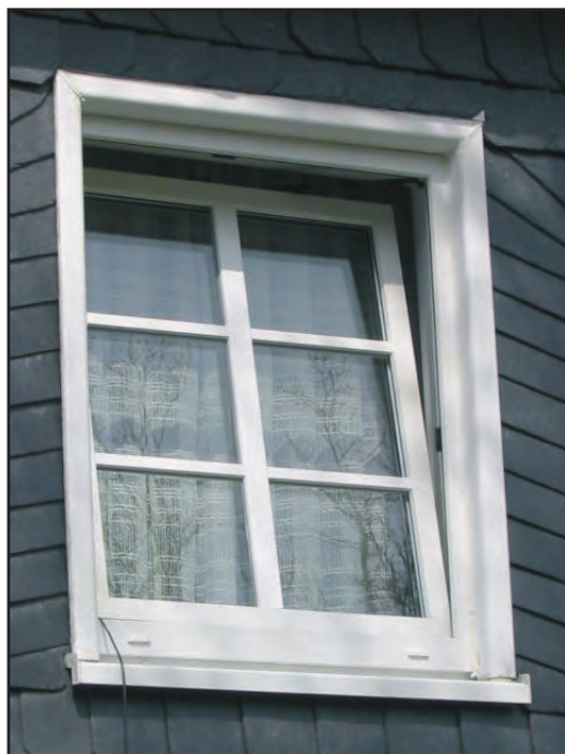
unten: 2-flügelige Kunststofffenster mit aufliegenden Sprossen, Bekleidung und weißer Fensterbank sind ausnahmsweise zulässig ...
