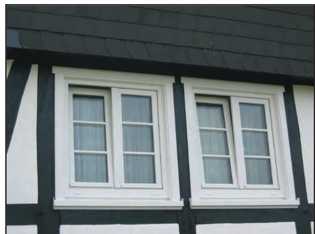
links: ... ebenso 1-flügelige Fenster mit vorgetäuschter 2-flügeligkeit, als Holz- oder wie abgebildet als Kunststofffenster
