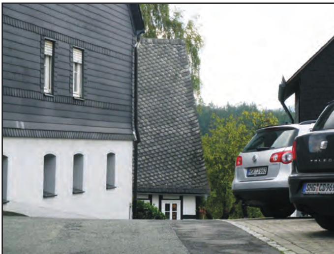
Gasse Mittelstraße/ Oststraße
