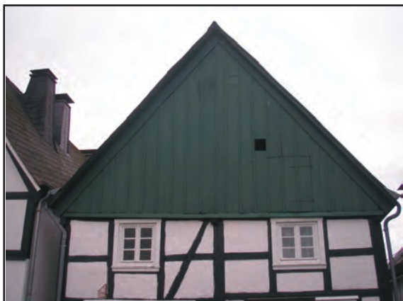
Holzverkleideter Giebel: An der Kirche 3
