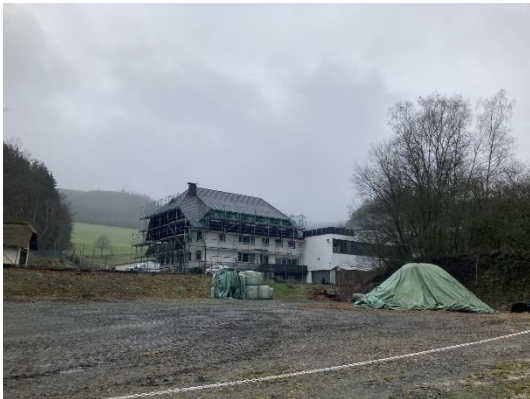
Abb. 9 Gebäude im südlichen Plangebietsbereich.
