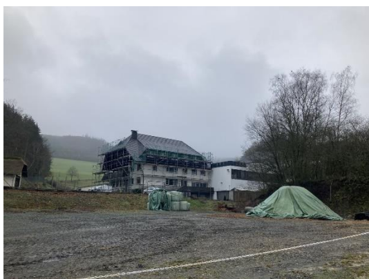
Abb. 7 Gebäude im südlichen Plangebietsbereich.
