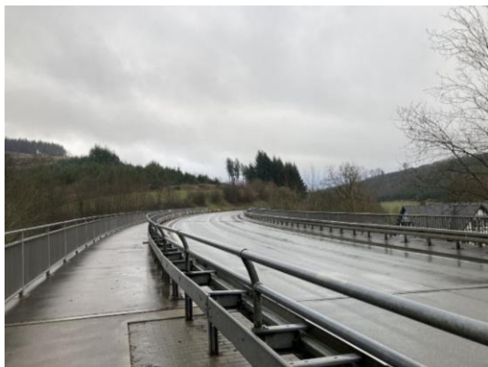
Abb. 7 Landesstraße mit Rad- und Gehweg in Brückenlage.
