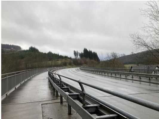
Abb. 5 Landesstraße mit Rad- und Gehweg in Brückenlage.
