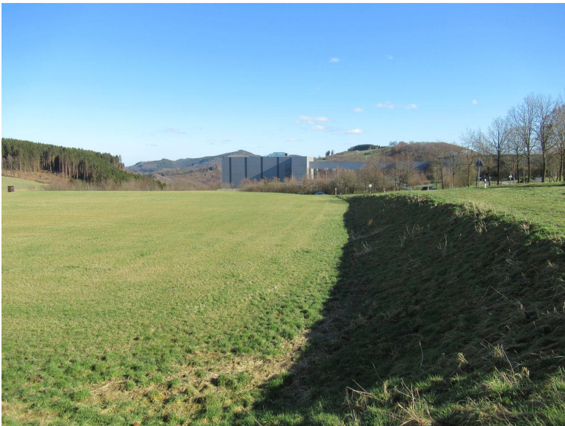
Abb. 21 Blick vom Plangebiet in östliche Richtung auf das Hochregallager der Brauerei VELTINS GmbH & Co. KG.
