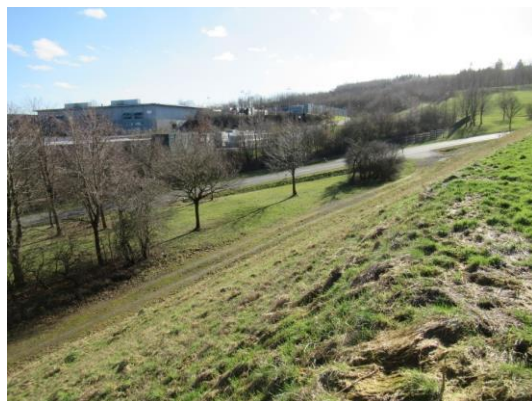
Abb. 13 Böschung der Bodenbefüllung mit Wirtschaftsweg.
