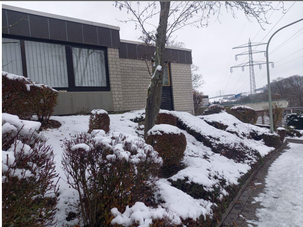
Abb. 5 Gebäude im Süden des Plangebietes.
