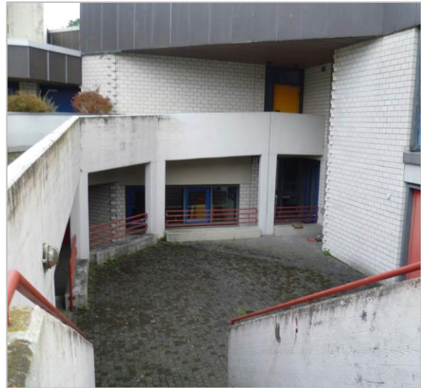
Abb. 21: Blick in den Hinterhof des ehem. Kirchzentrums (Eigene Aufnahme)
