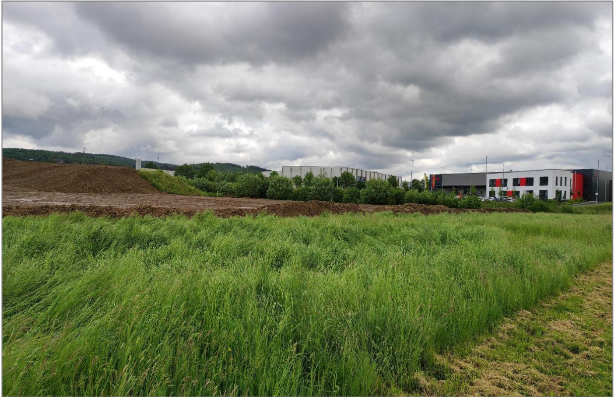
Abbildung 8: Südöstlicher Teil des Plangebiets welcher bereits durch bauvorbereitende Maßnahmen beansprucht wird.
