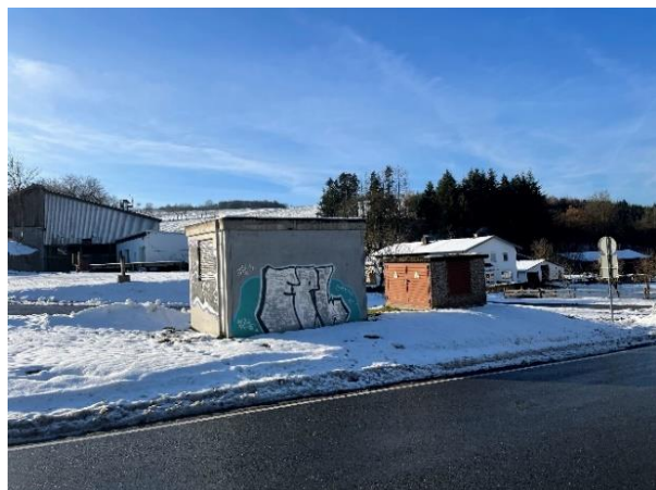
Erschließungs- und Versorgungsfläche mit Trafostation (© Eigene Aufnahme, Dezember 2023)
