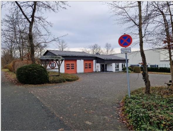
Abb. 5: Feuerwehrgerätehaus (Eigene Aufnahme, Januar 2024)
