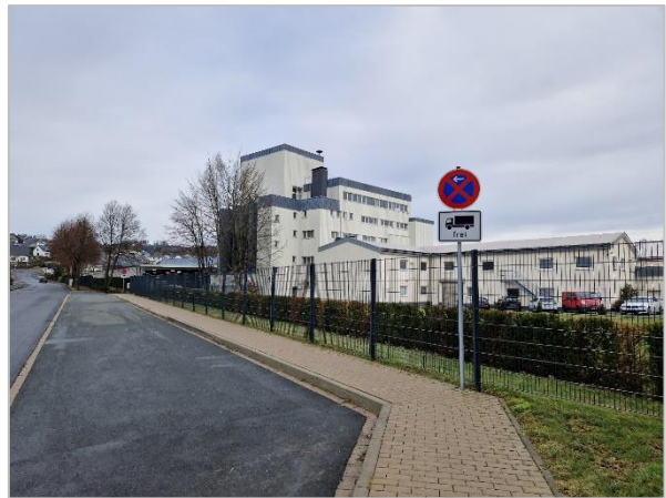
Abb. 8: Blick auf einen Teil des Betriebsgeländes (Eigene Aufnahme, Januar 2024)
