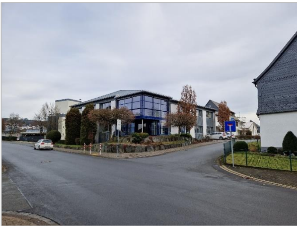
Abb. 7: Empfangs- und Bürogebäude (Eigene Aufnahme, Januar 2024)
