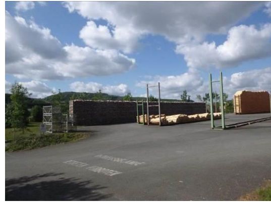
Abb. 8 Versiegelte Fläche mit Holzlager.
