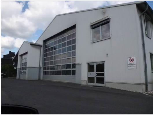
Abb. 7 Bestehendes Gebäude im Plangebiet.
