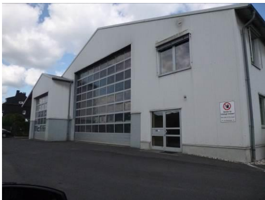
Abb. 5 Bestehendes Gebäude im Plangebiet.
