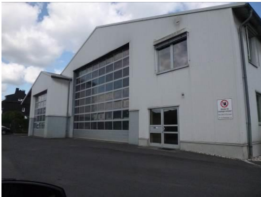
Abb. 7 Bestehendes Gebäude im Plangebiet.
