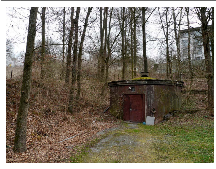
Bild -5- Umzäunte Parzelle mit wasser- wirtschaftlicher Alt- Anlage innerhalb einer umzäunten Parzelle des unteren Talraumes.
