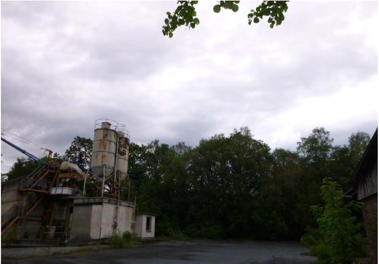
Foto 2: 03.06.2019: Horchbox 3 ausgerichtet auf das Hofgelände.
