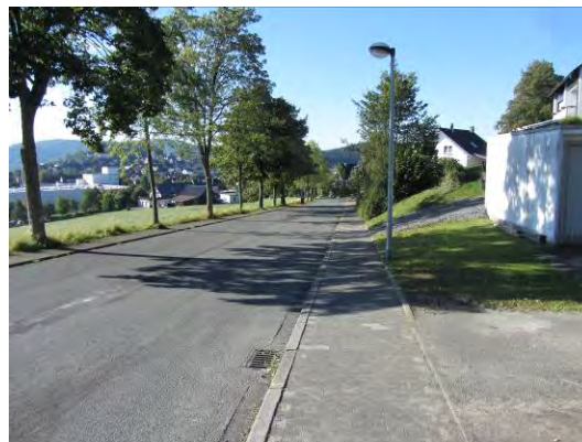
Abb. 10 Gehweg an der Straße „An der Buchsplitt“ im nördlichen Bereich des Plangebiets.
